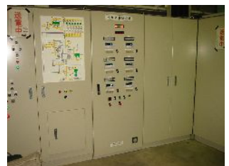
写真: 左 セメント出荷用トラックスケール 写真: 左下 樹脂用ホッパースケール 写真: 右下 配合設備制御盤
